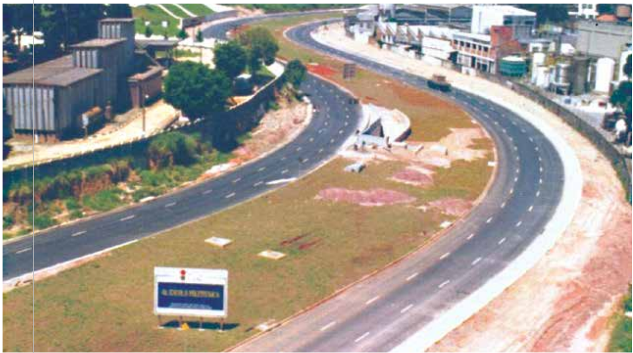
Alcaldía Municipal de São Paulo Canalización del Arroyo Jaguaré y Construcción de la Av. Escola Politécnica São Paulo City Government | Channelization of the Jaguaré Creek and Construction of Av. Escola Politécnica
